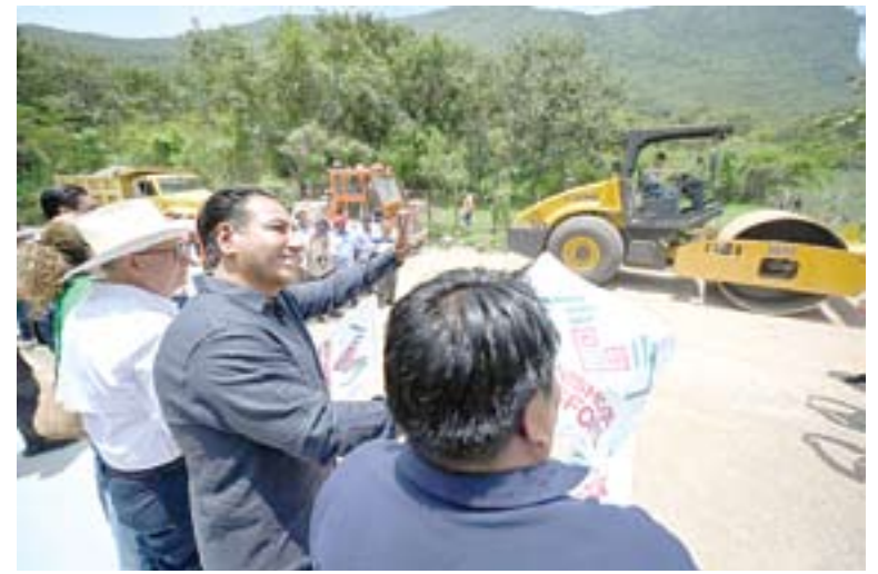
En la rehabilitación del camino Soyaló-Francisco Sarabia-Chicoasén, se invertirán 27 mdp. Cortesía
