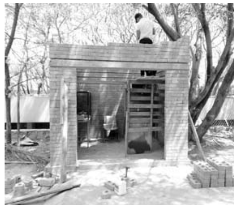
El bloque se puede hacer de la tierra que se extrajo, previamente estudiado en su composición. CP
