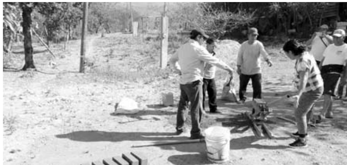
Los bloques y su sistema cumplen la normatividad nacional de construcción. CP
