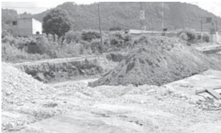
Debido a la realización de las obras en la zona, el cierre de vialidad tendrá una duración aproximada de 40 días. Manuel Martínez / CP
