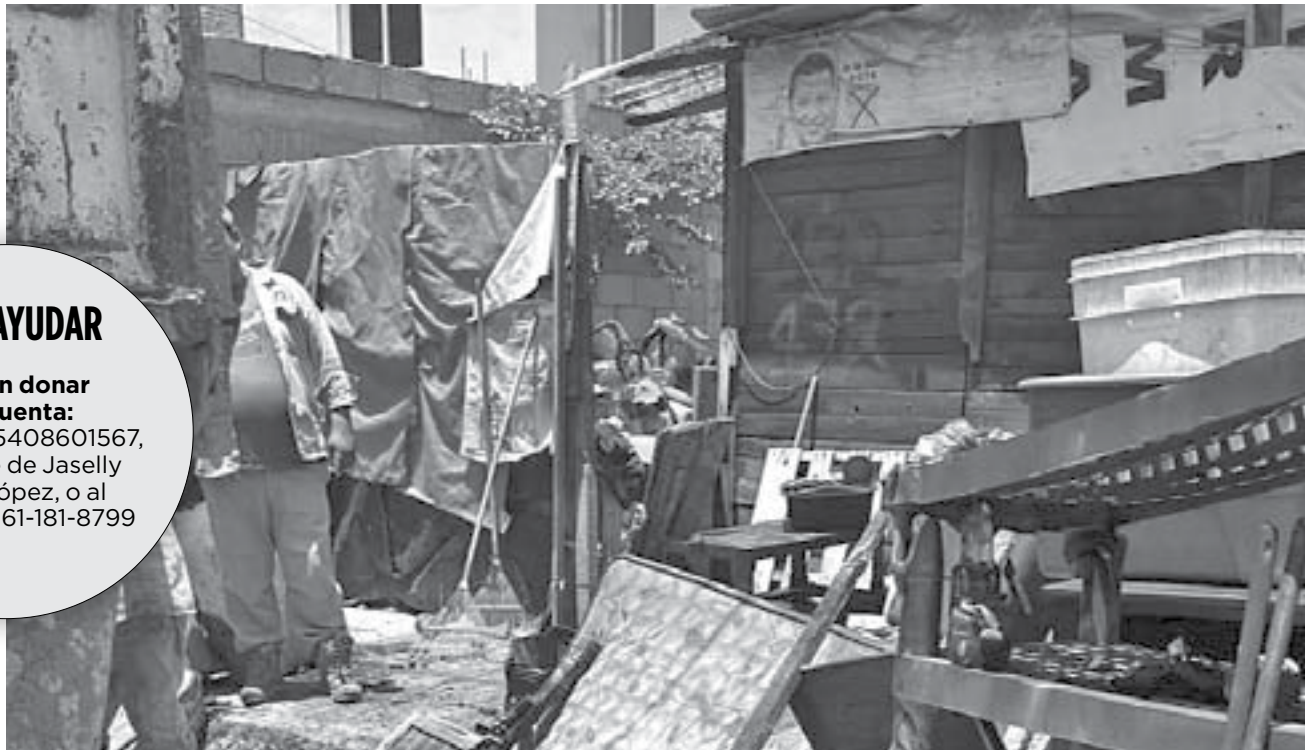
Aspecto de la vivienda, que quedó con daños estructurales. CP
