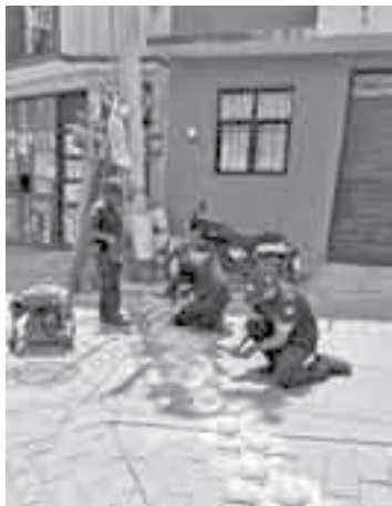
Los trabajos de sustitución de boyas reductoras estuvieron a cargo de personal de Tránsito Municipal. Manuel Martínez / CP
