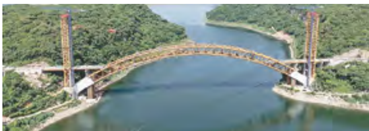
En la imagen que publicó la SICT se observa el avance de la obra. Cortesía
